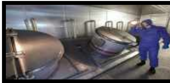
Ammonia Integrity Survey
